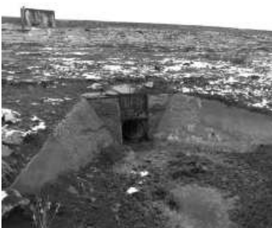
Golirea de fund amonte baraj
