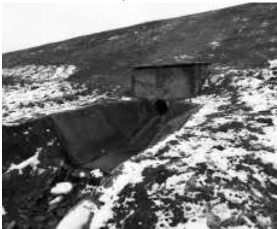
Golirea de fund aval baraj
