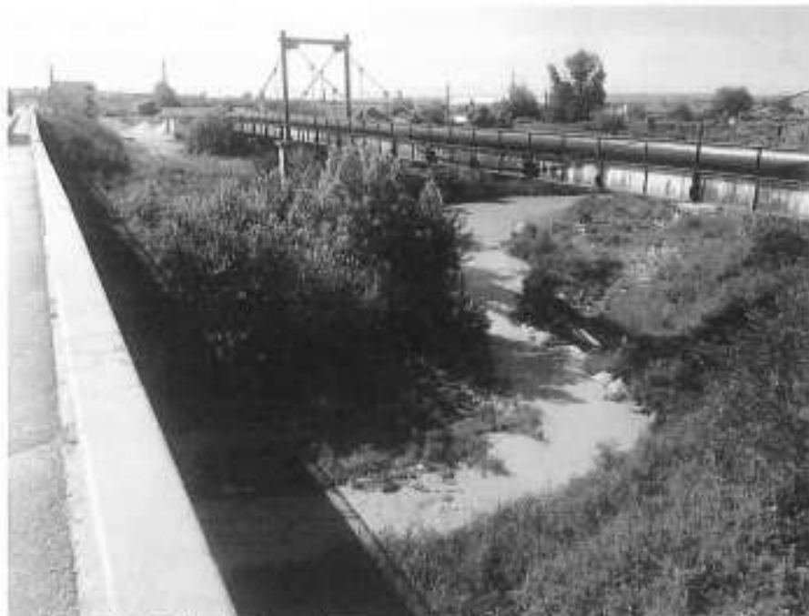
Foto III.4.2.1.- Vedere de pe pod mal drept spre aval mal stâng
