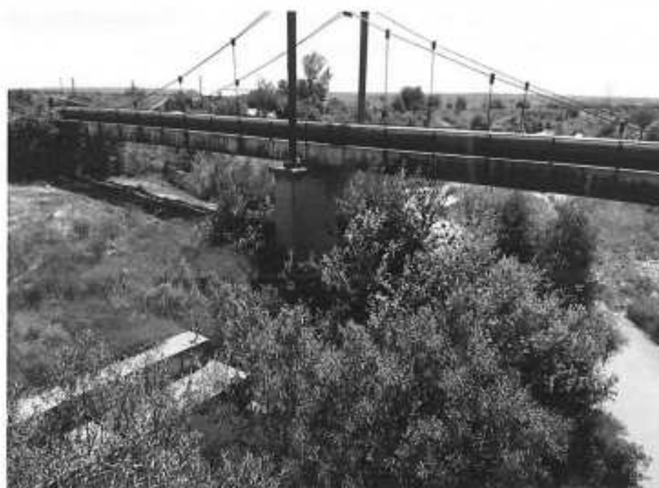
Foto III.2.1. -Vedere de pe pod spre mal drept, zid gabioane existent
