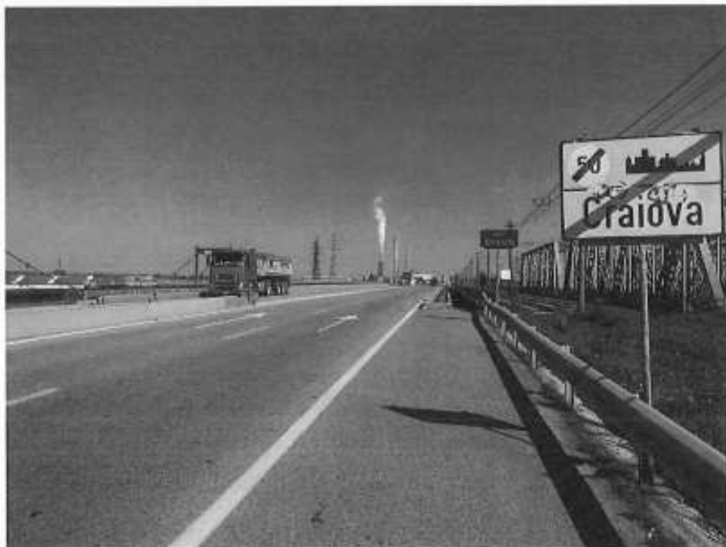
Foto III.1.1: Vedere pod spre Ișalnița
