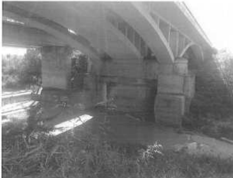
Figura III.3.1.1 -Vedere pila P1 supusa afuierilor
