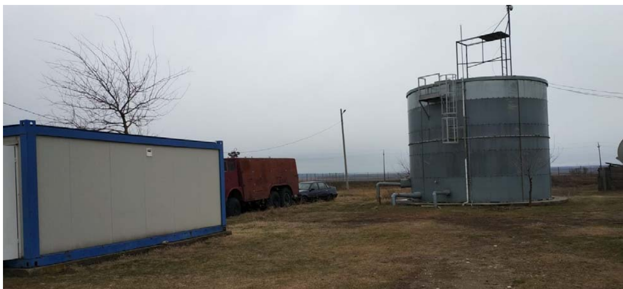
Foto2: Container pentru statia de pompare si bazin de apa din gospodaria de apa exisntenta
