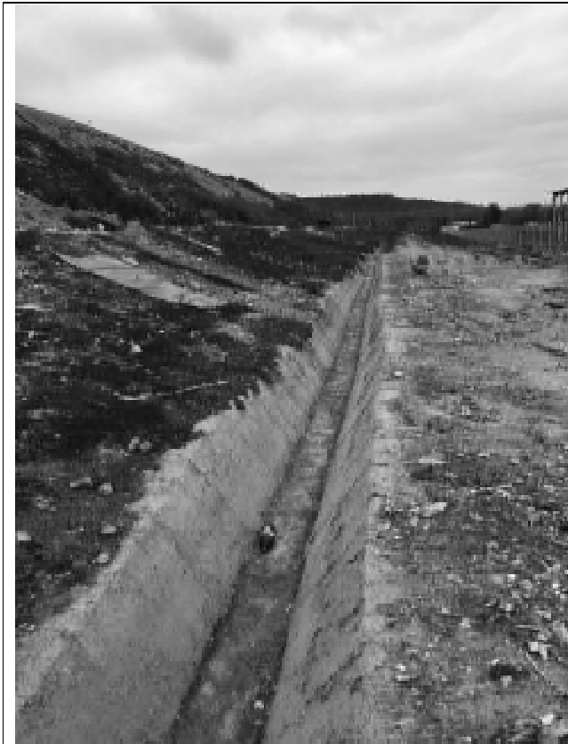
Celulele 3-4 strat de acoperire temporara (vedere sant de colectare ape pluviale)
