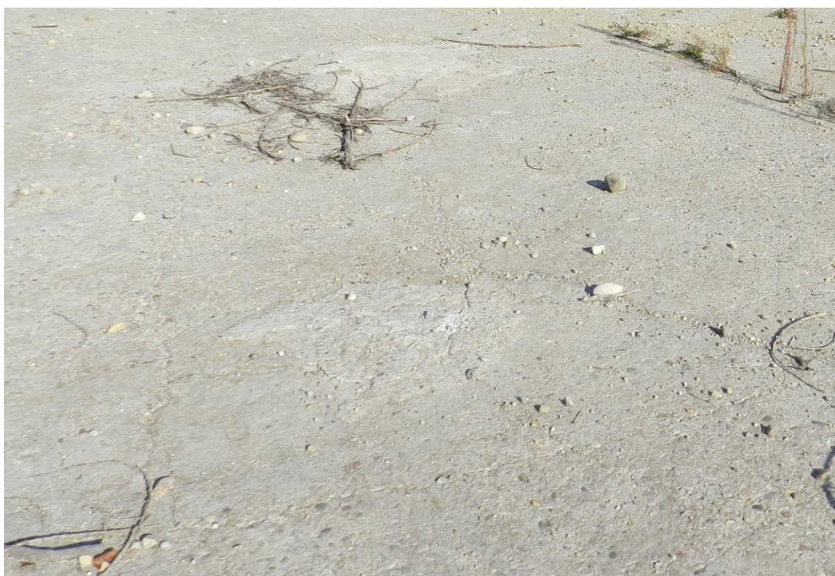
Fig. 2 – Platformă betonată existentă pe amplasament
