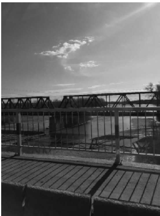
Foto 2.3.1. Traversare DN56 - pod peste râul Jiu în zona PUG dinspre Podari spre Balta Verde (Pozitia preluării fotografiei este marcată pe harta Google Earth).
