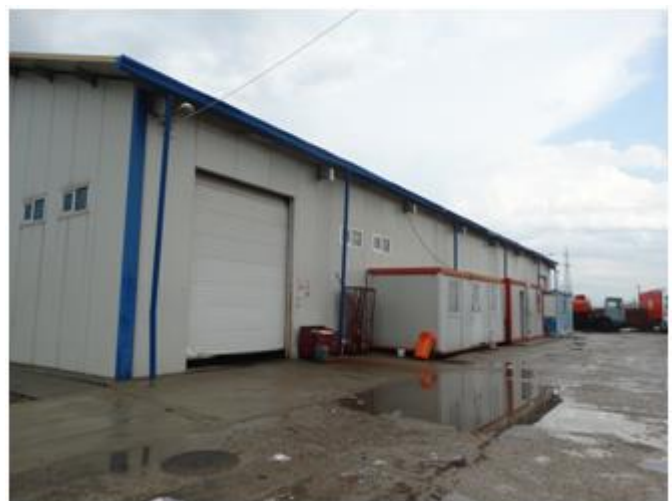
Figura 4-6: Imagine stația de sortare Tecuci
