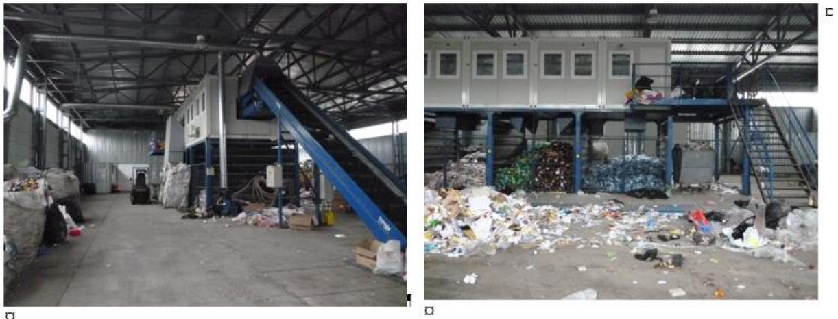
Figura 4-5: Stația de sortare Galați
