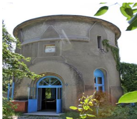
SCADA Turnul de apa (foto 8)
