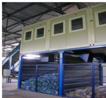
Stația de sortare Galați
