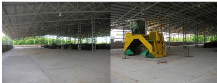
Stația de compostare Galați
