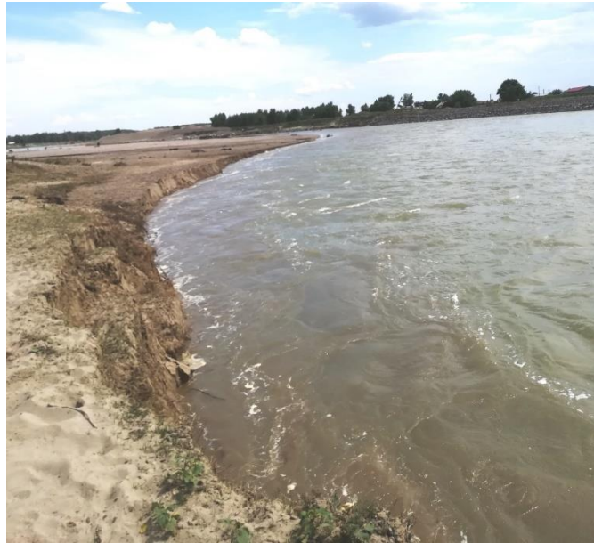
Fig. 25 Deviere curent principal către malul drept, de către depozitul Condrea Aval
