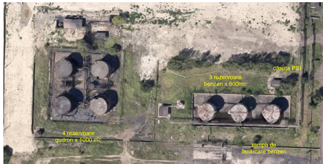
Depozitul II de benzen și gudron – Rampa de încărcare în cisterne CF
