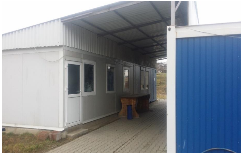
Model de organizare de șantier realizată din containere mobile
