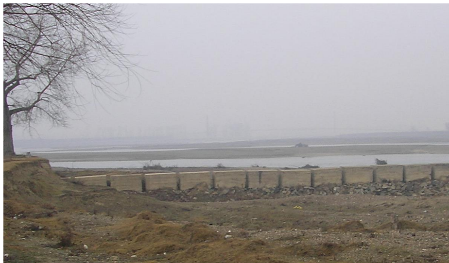
Fig 5 . E-piu din beton in capatul amonte al perimetrului S.C. Somaco Holding S.A.
