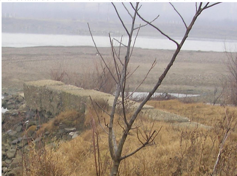
Fig 6 . E-piu din beton in capatul aval al perimetrului S.C. Somaco Holding S.A.
