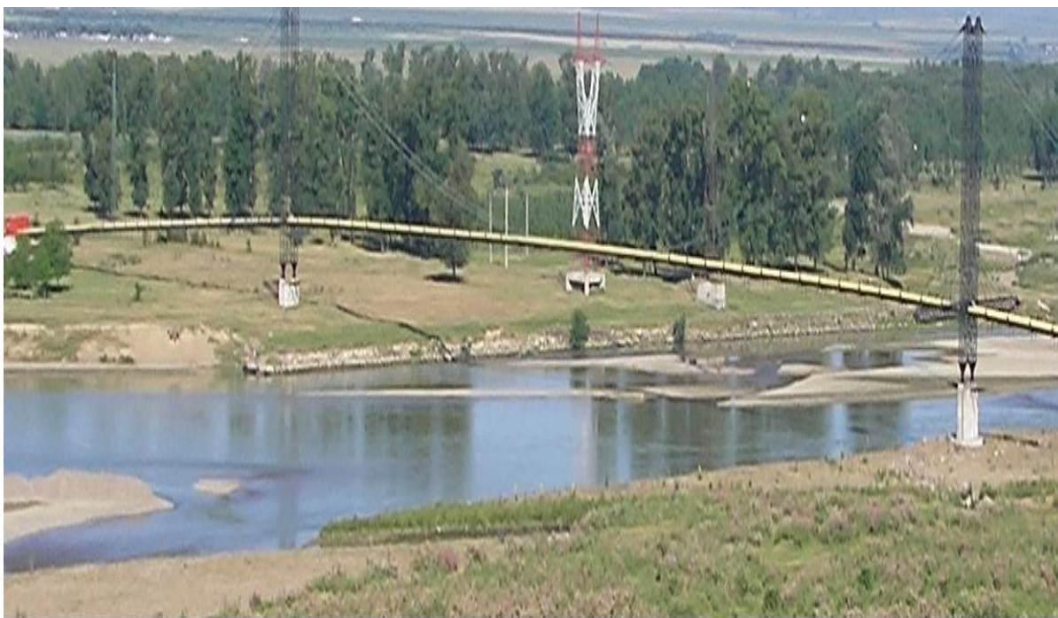
Fig 8. Conducta de gaze situata in amonte de perimetru
