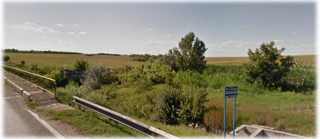
Figura nr. 7: Paraul Tecucel, imagine din drumul national DN 24, imagine catre nord-vest, amonte
