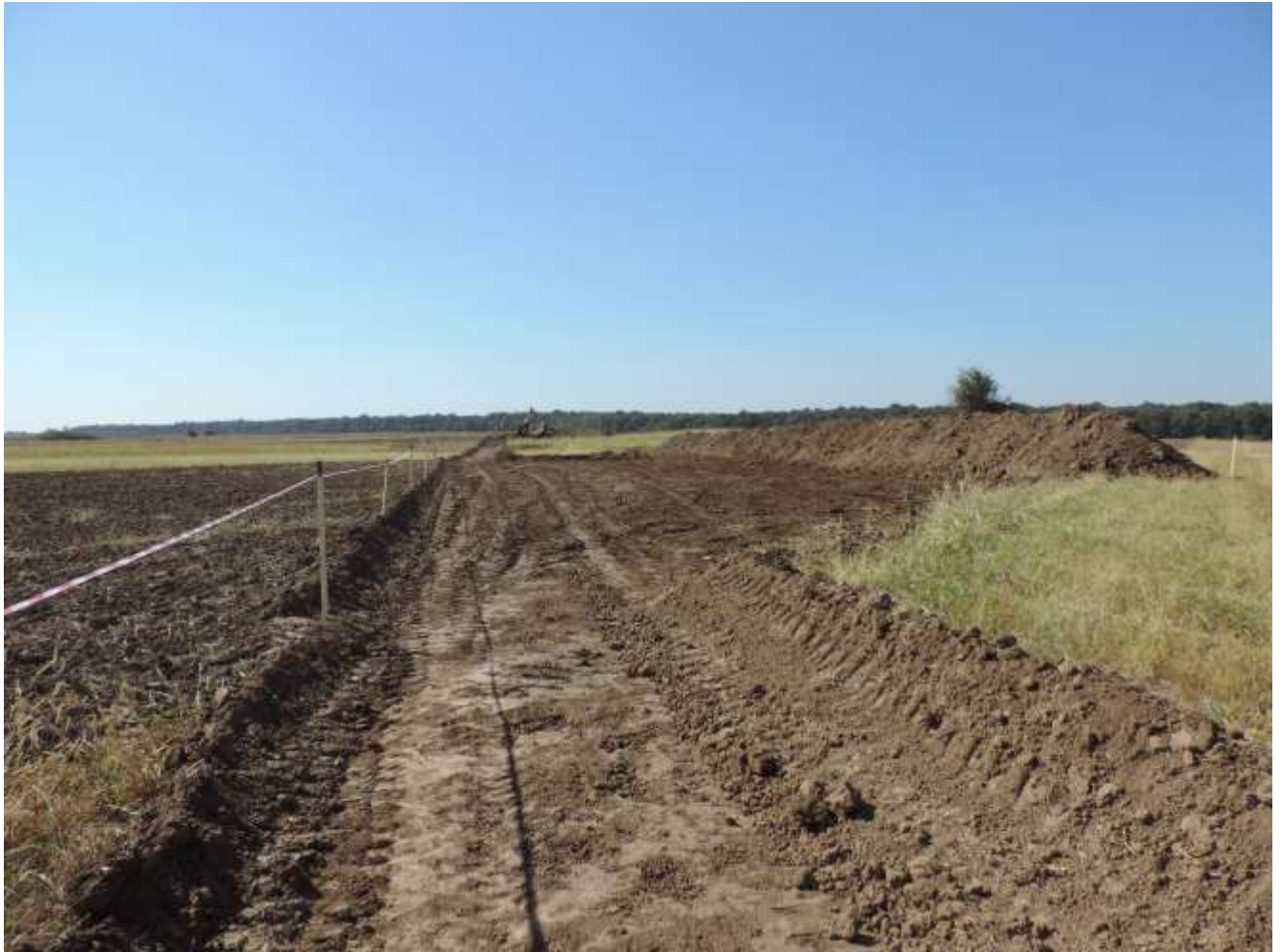
Figura 23. Aspect al acțiunilor de decopertare a solului vegetal
