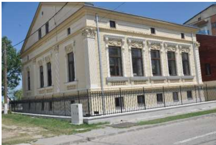
Fig. 2. STAȚIA DE CERCETARE ÎN TEREN SULINA – Clădirea Staționarului Sulina
