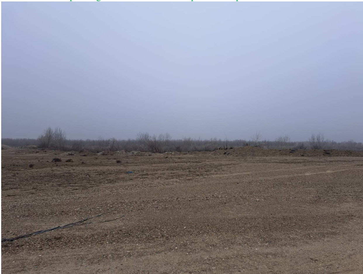
Figura nr. 156. Vedere de ansamblu asupra amplasamentului analizat
