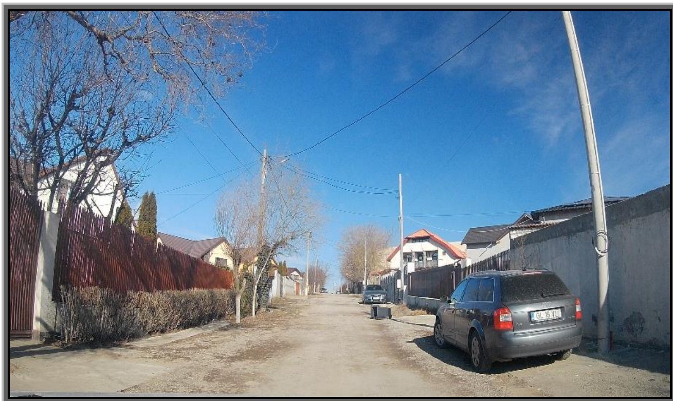
Figura 04. Prezentarea situației existente a drumurilor locale din comuna Sendreni, județul Galați.
