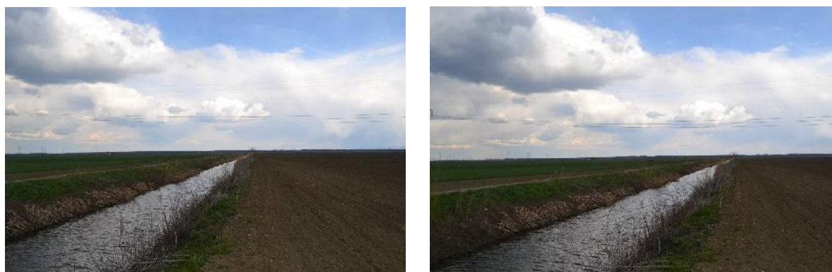
Figura 29. Canal existent în zona km 6+078
