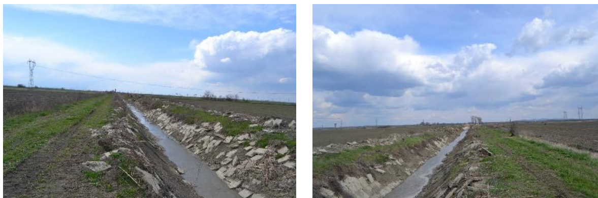
Figura 28. Canal existent în zona km 4+290
