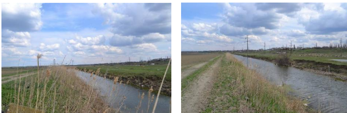
Figura 26. Canal existent la km 1+594 al drumului expres Brăila – Galați
