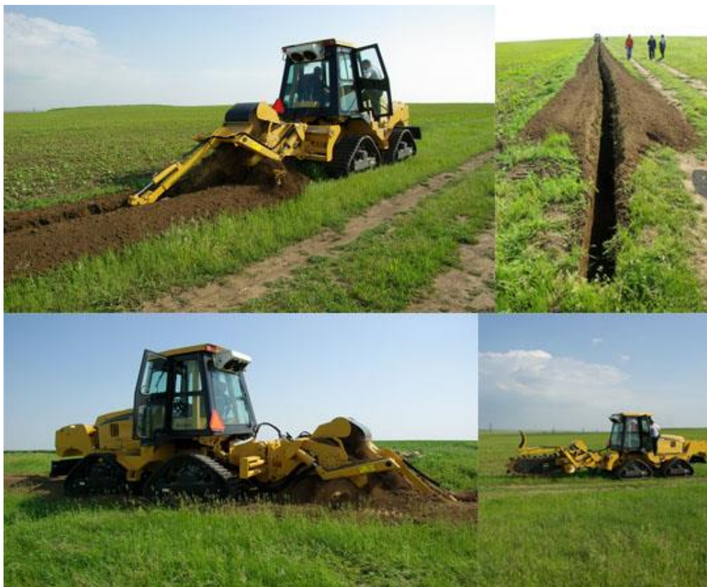
Figura 1. Modul de execuție al șanțului
