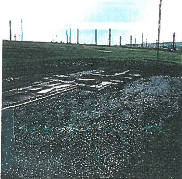
Foto 19: Careu sonda dupa montare blinda (1)
