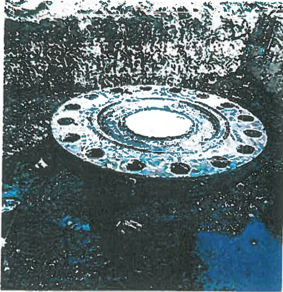
Foto 17: Completare coloana 6 5/8" cu pasta ciment la zi
