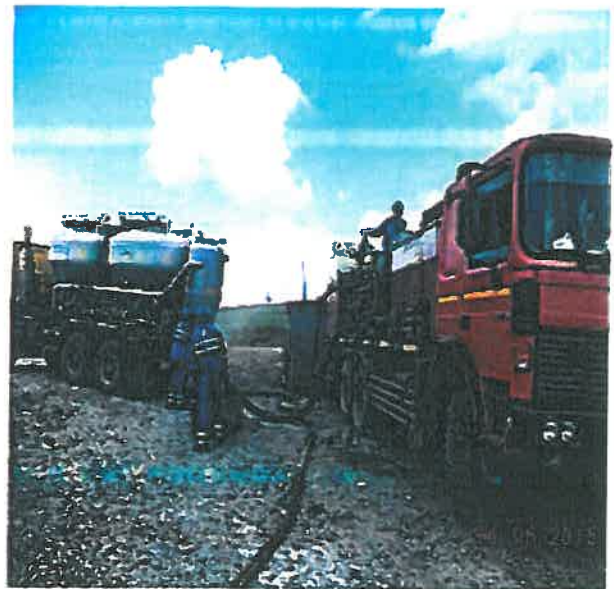
Foto 16: Cimentare coloana 6 5/8" cu 1,1 to ciment; interval (54 – 0 m)
