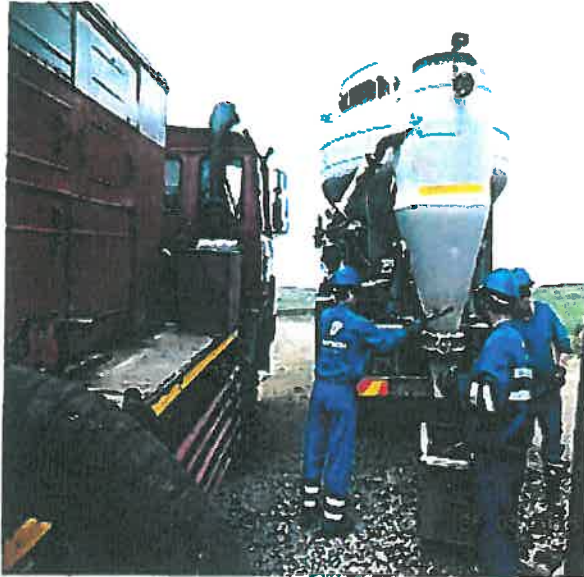
Foto 13: Cimentare coloana 6 5/8" (sabot la 672 m) cu 0,3 to ciment
