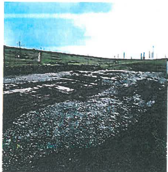
Foto 24: Careu sonda dupa montare blinda (3)
