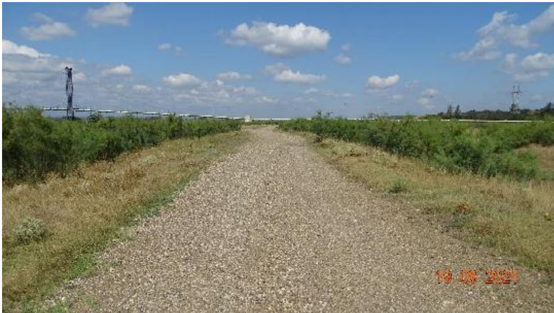
Figura nr. 9 Aspect al drumului de acces către gara de lansare/primire godevil existentă
