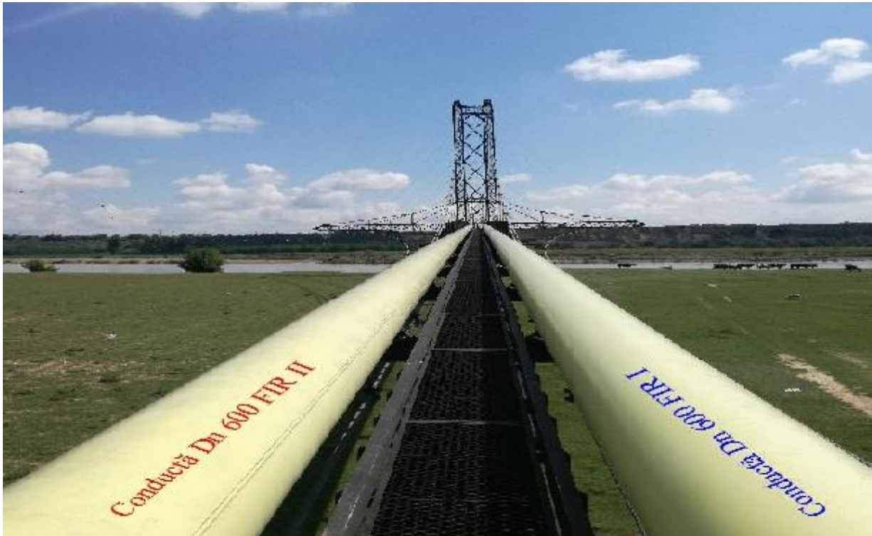
Figura nr. 2 Traversare râu Siret cu conducte Dn 600 FIR I și FIR II (Vedere de pe malul drept)
