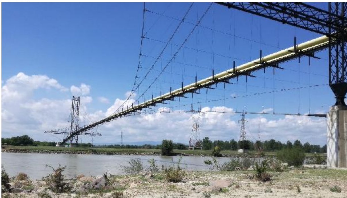
Figura nr. 1 Traversare râu Siret cu conducte Dn 600 FIR I și FIR II (Vedere de pe malul stâng)
