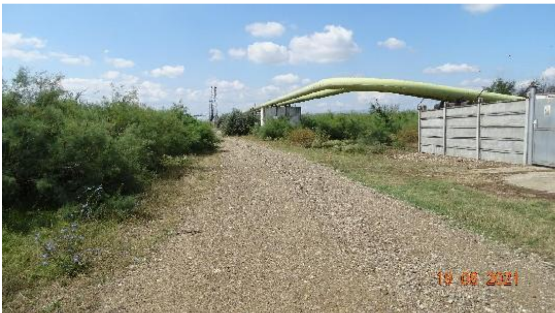
Figura nr. 10 Aspect amplasament gara de lansare/primire godevil existentă
