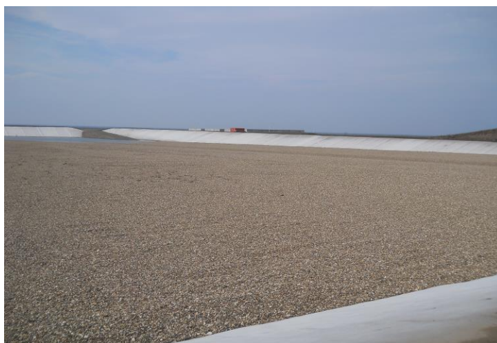
Depozitul de deșeuri industriale nepericuloase OMV Petrom
