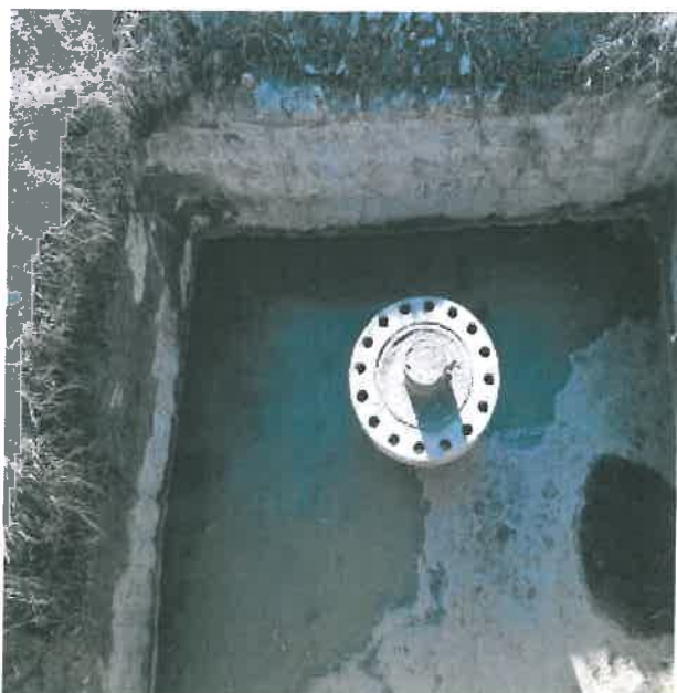
Foto 13: Sonda 366 MP Schela Nivelul de ciment la zi.
