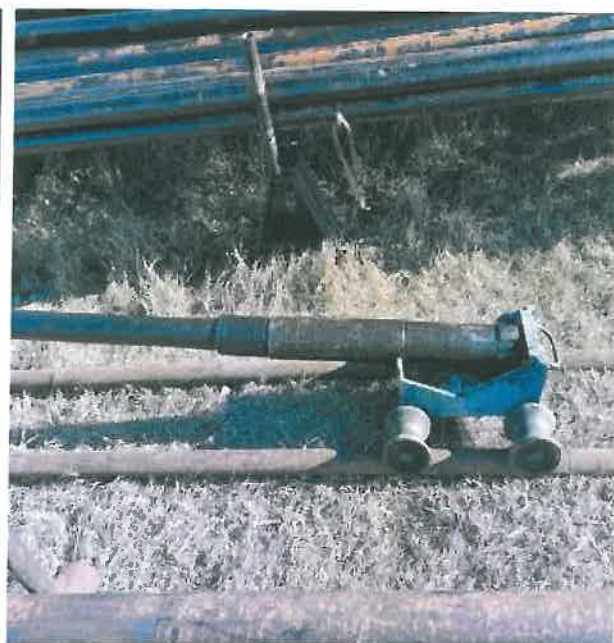
Foto 8: Sonda 366 MP Schela Freza d = 114 mm data pe rampa pentru demontare.
