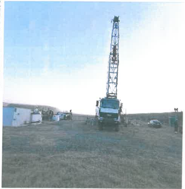
Foto 2: Sonda 366 MP Schela Instalatia AM 12/50 montata.
