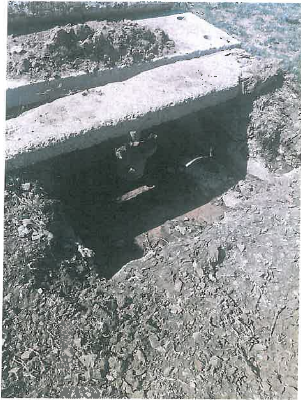
Dale beton + cap sonda
