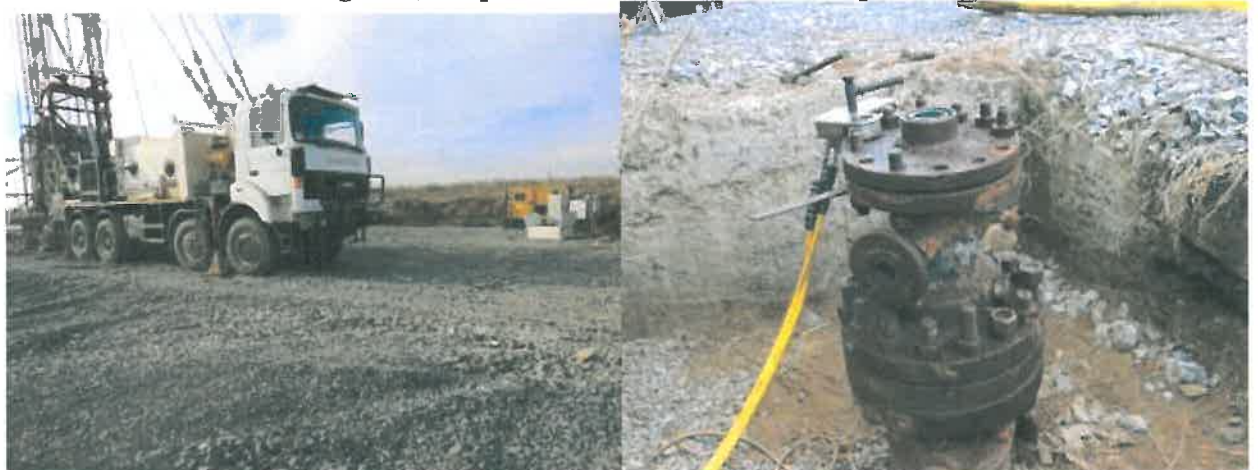
Fig.3,4 5,6 : Operatia de montare instalatie de prevenire;
