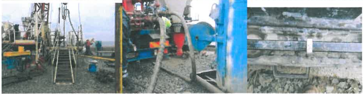
Fig.22: Completarea cu pasta de ciment la gura, in coloana de 6 5/8";
