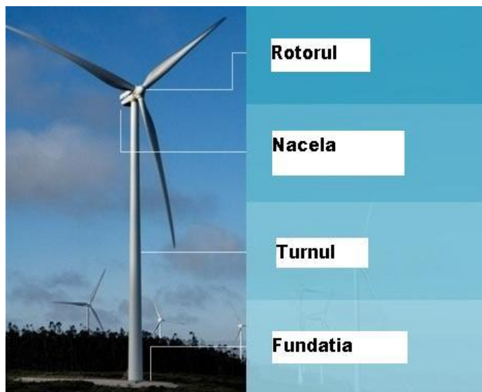
Figura 4 - Componentele principale ale turbinei
