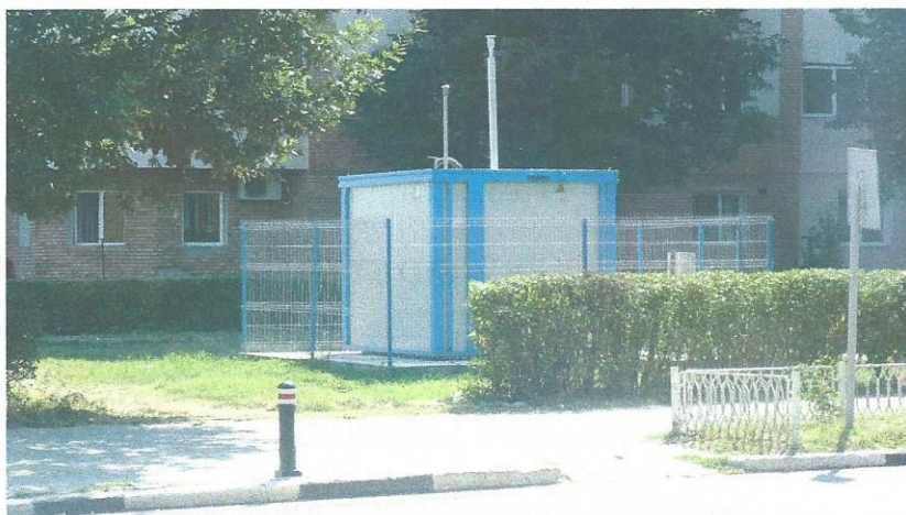
Stația de trafic GR 1
