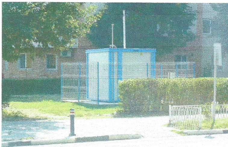
Stația de trafic GR 1
