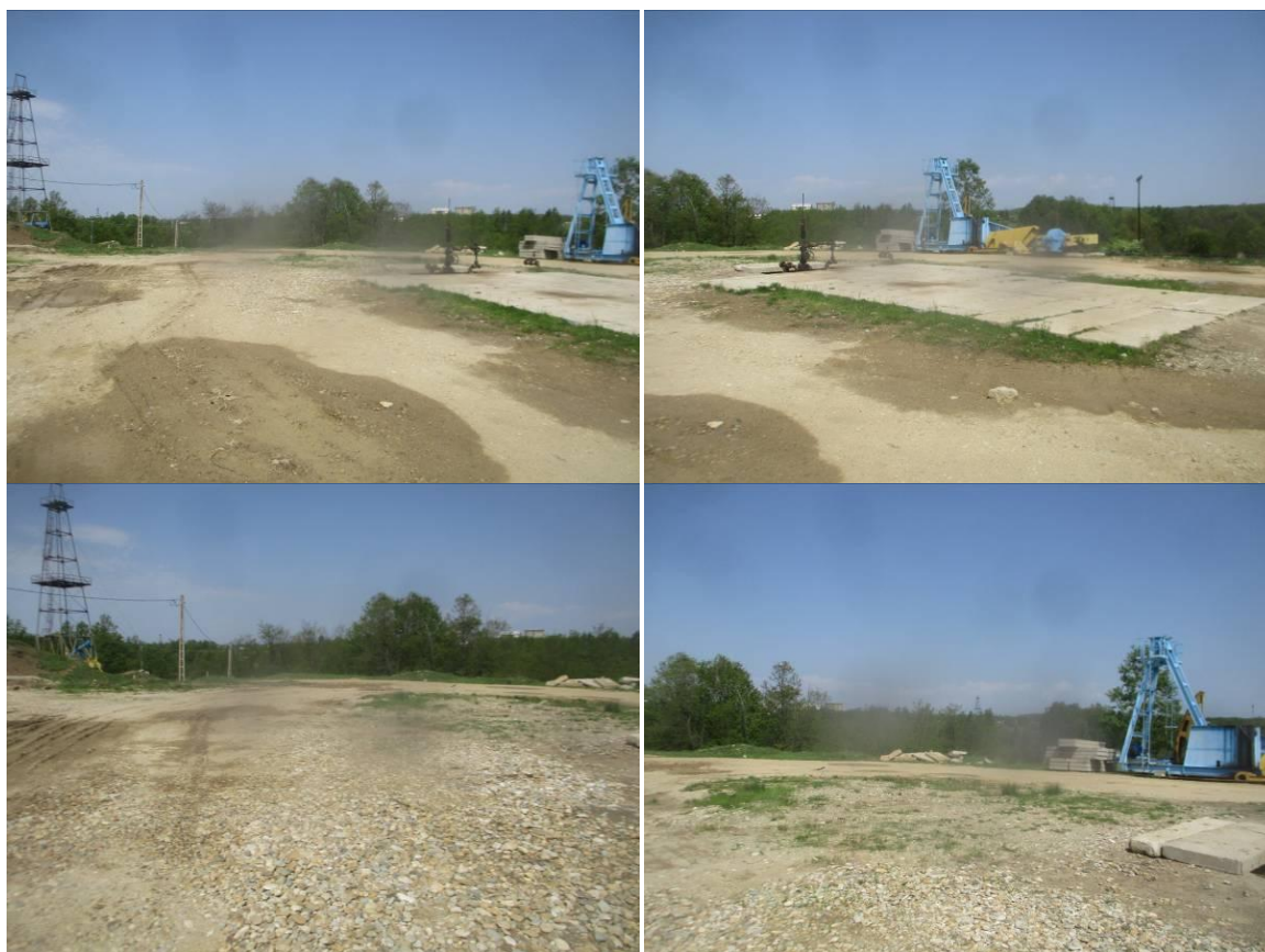
Imagini cu platforma existenta a sondei 387 Ticleni pe care urmeaza a se amenaja platforma necesara forajului sondei 522 Ticleni
