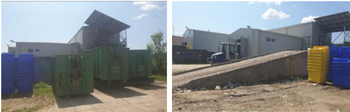
Figura 4.9. Stația de transfer și sortare Novaci
