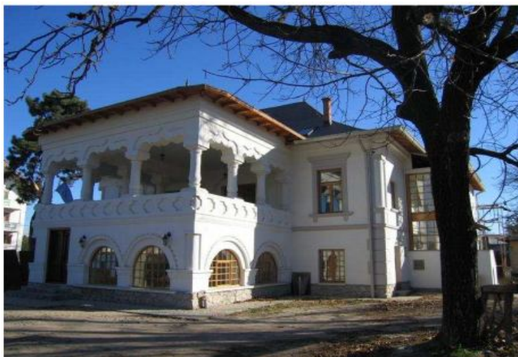
Fig. nr. 21 Casa Dimitrie Măldărăscu
