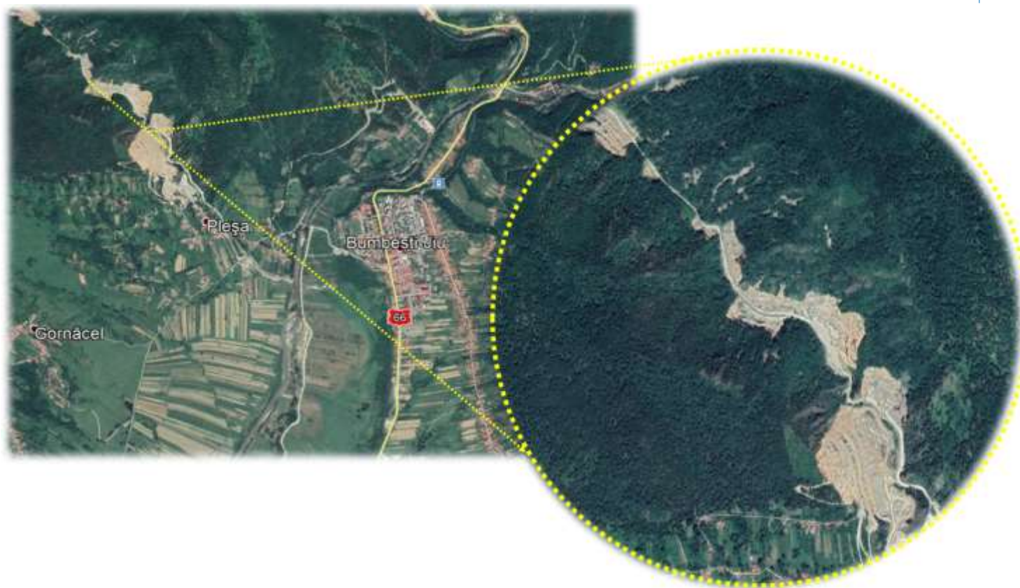
Fig.5.1 Carieră – extracția agregatelor minerale
