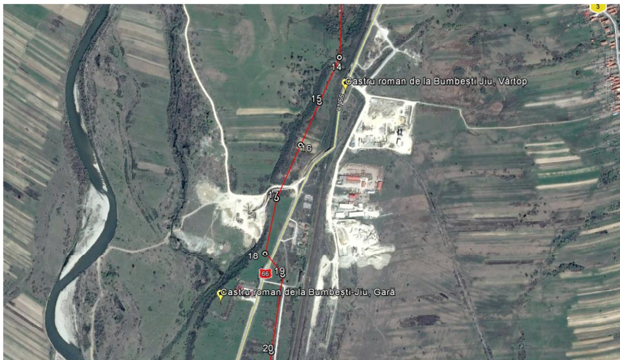
Figura B.2.4. -Traseul LEA 110 kV d.c. CHE Bumbesti - borna 35 bis în raport cu Monumentele Istorice
