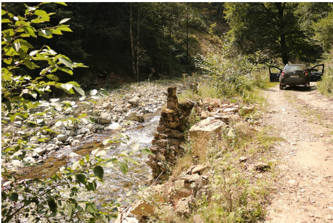
Figura 19 - Aspect din teren - talveg drum afectat de ape
