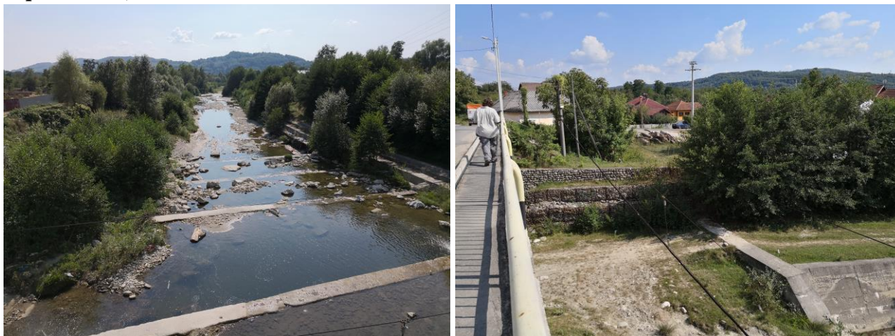
Figura 10 - Aspecte din zona sudică a amplasamentului lucrării. Se observă infrastructura existentă care se propune reabilitată (foto: Neațu Sabin)
