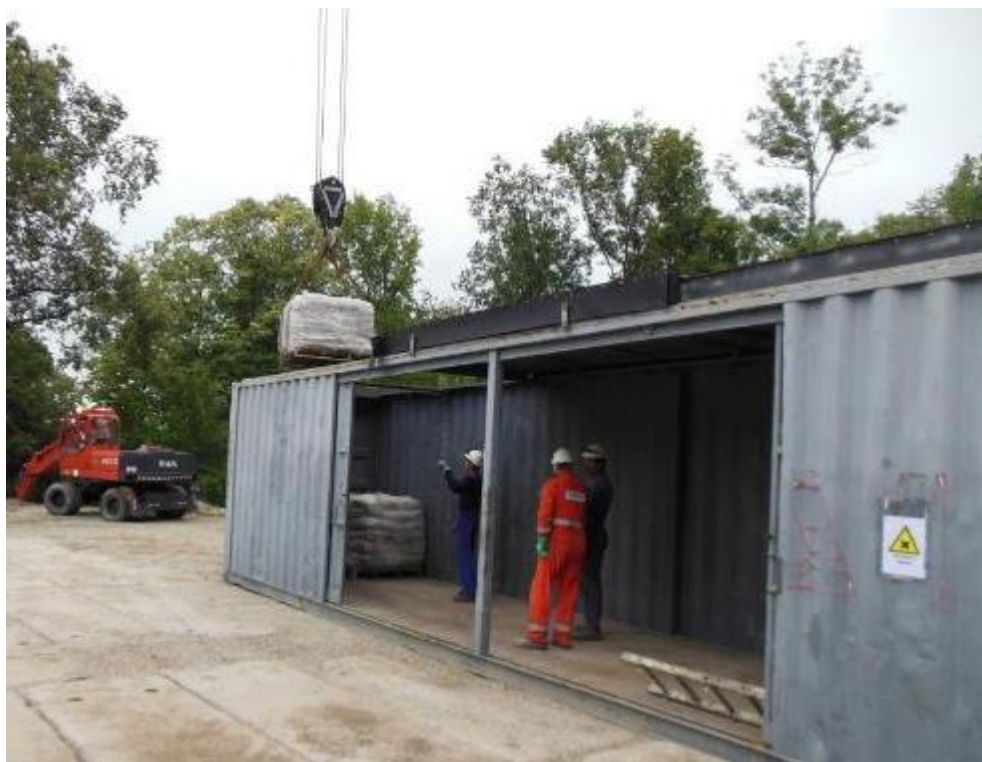
Figura nr. 1-6 Baracă de chimicale amplasată pe una din locațiile Amromco Energy SRL
