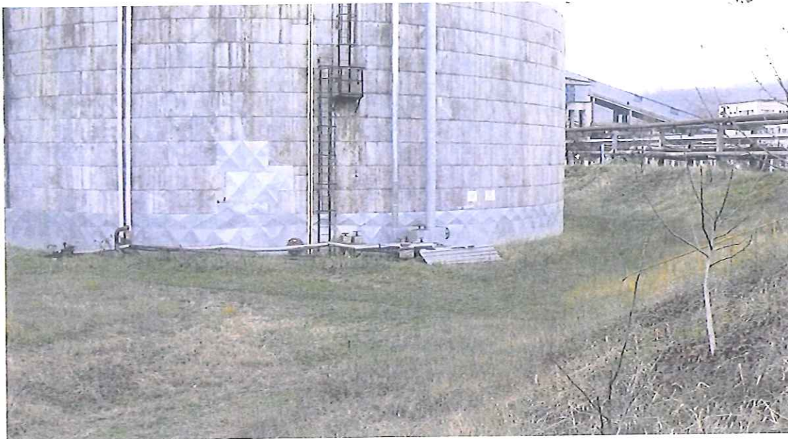
R1 – Rezervor păcură
