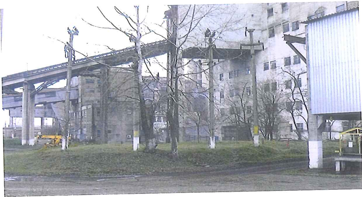
F5 Secția exploatare cazane concasare 1+2, poarta 3
