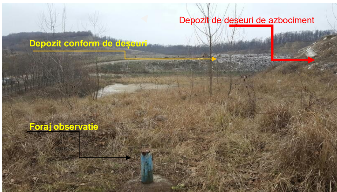
Foto 1.1: Depozitul de deșeuri de azbociment
