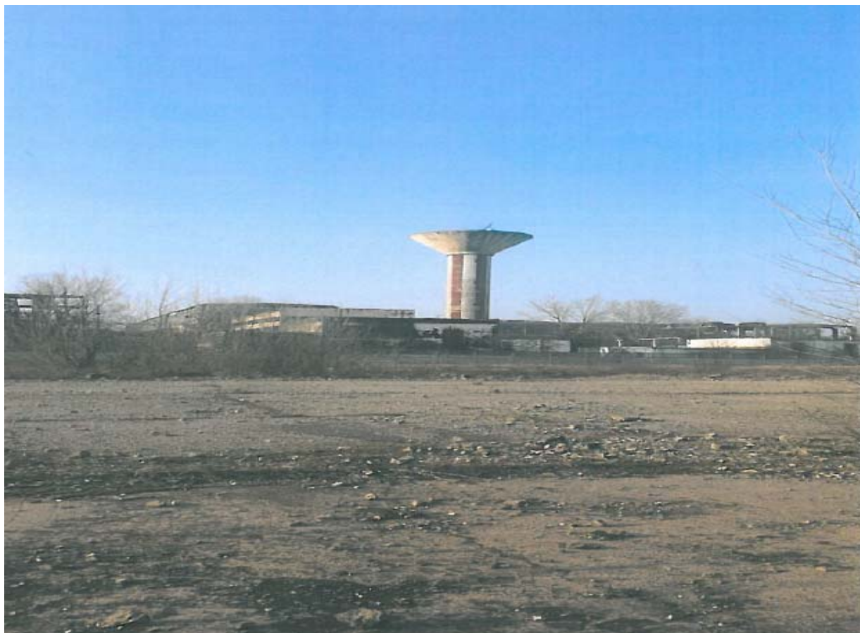
Figură 4 – Vedere de la teren spre Nord – Subzona I3 (ZIROM SA)
