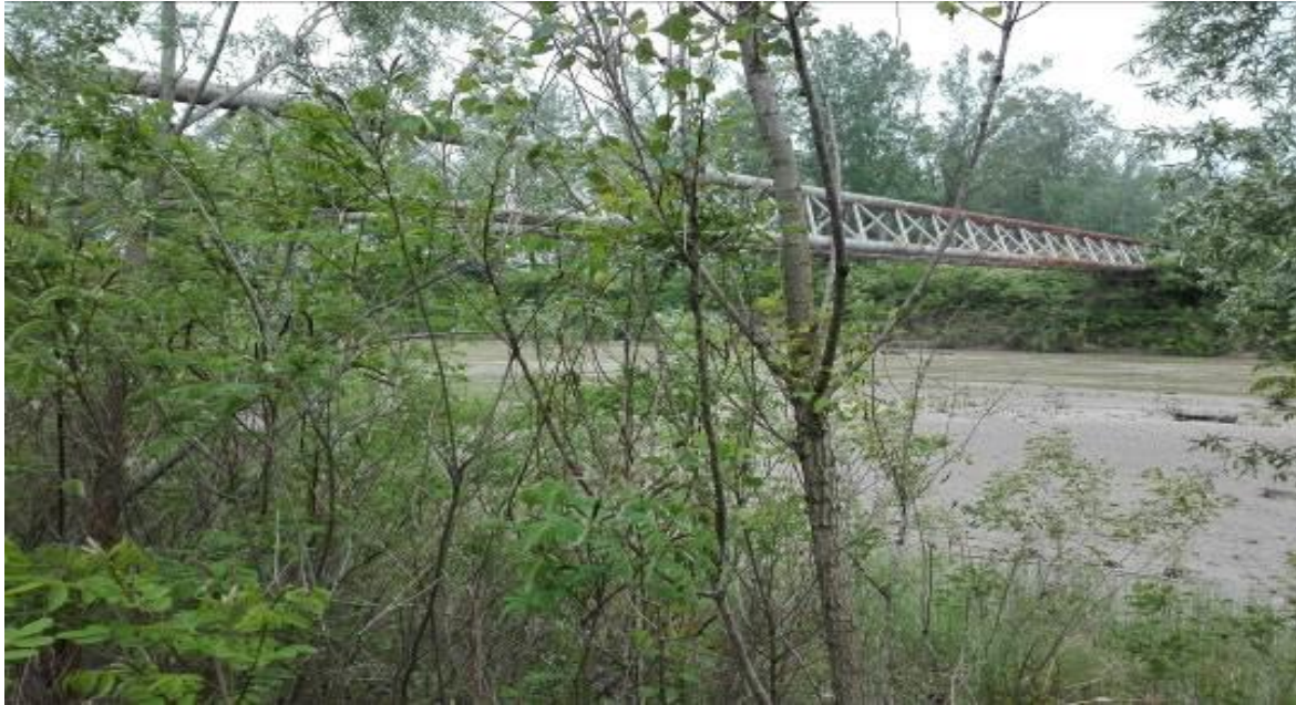
Figura nr.2.1.1- 2. Traversare aeriana a raului Arges, cu conductele de transport titei Cartojani - Ploiesti
