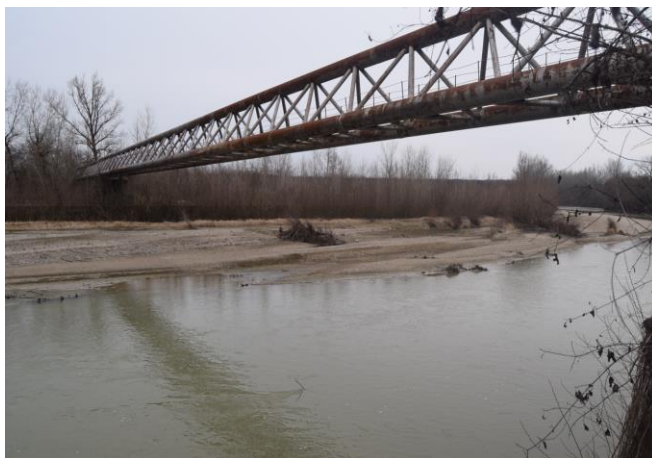
Foto4: Zona traversare raul Arges - Estacada judetul UAT Gaiseni, Giurgiu
