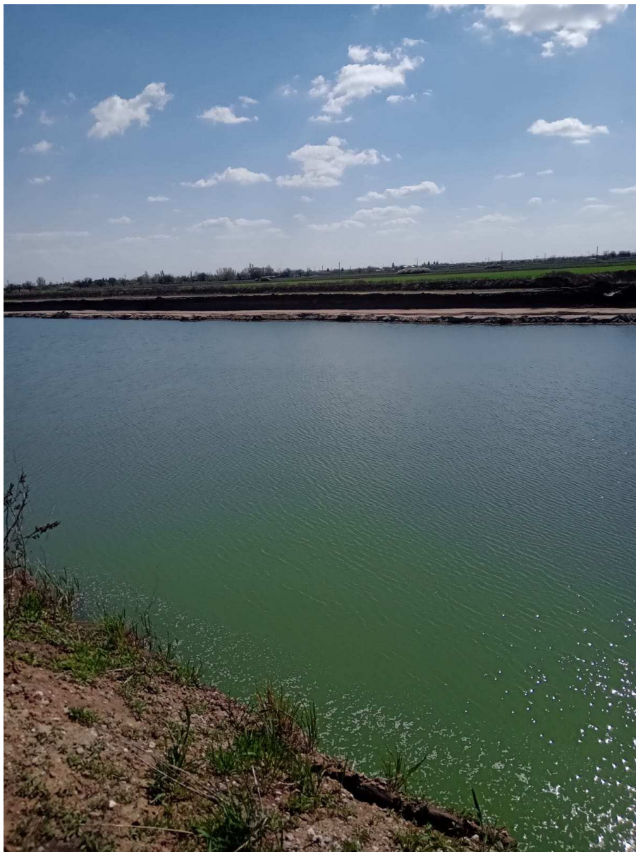
Figura. 24. Vedere bazin piscicol existent
