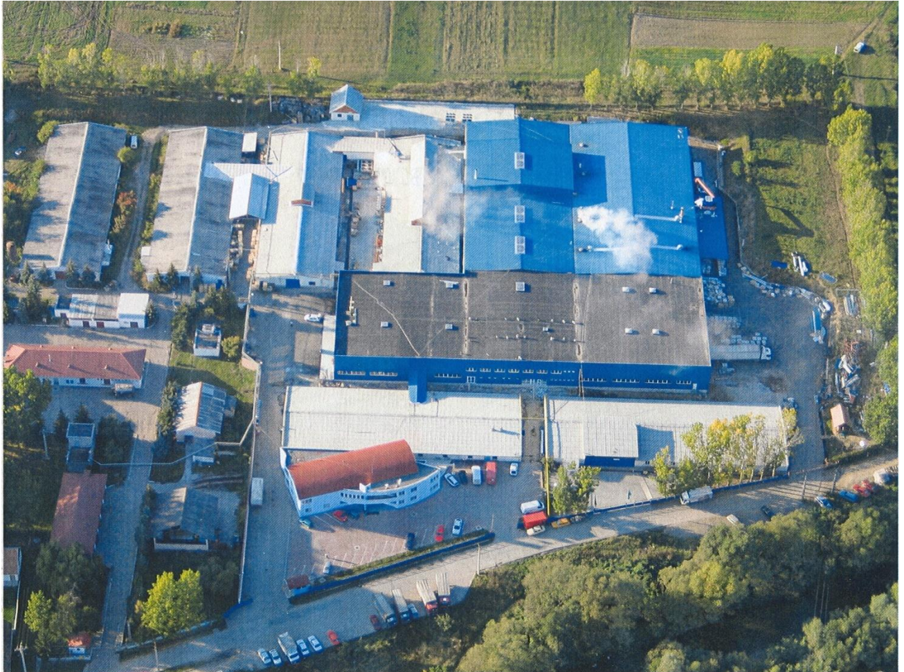
Fig. nr. 11. Incinta instalației de tipărire
