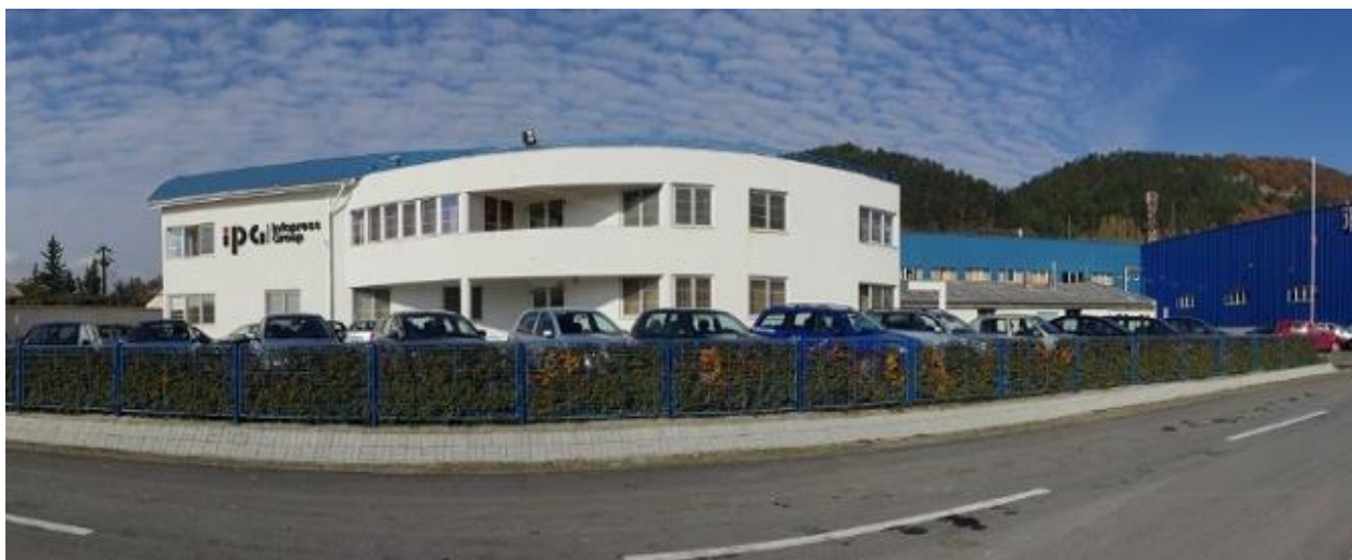
Fig. nr.3. Vedere generală SC Infopress Group SA Odorheiu Secuiesc
