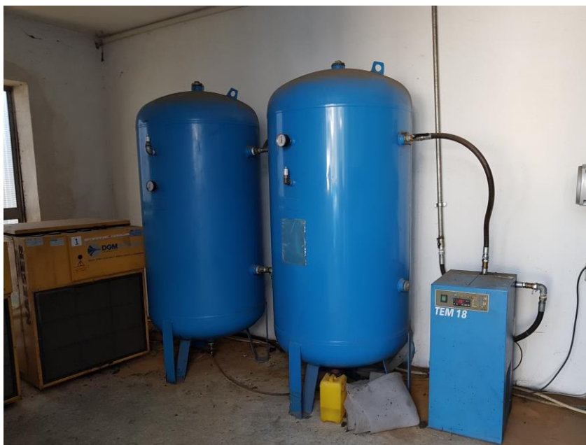
Figura 7. Compresor, Butelii de aer comprimat pentru curățarea mașinilor de injecție
