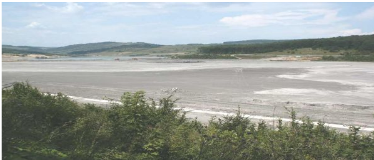
UMECTAREA DEPOZITULUI DE ZGURĂ-CENUȘĂ
