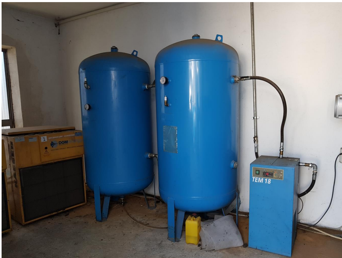
Fig. 2.3.2. - Compresor, Butelii de aer comprimat pentru curățarea mașinilor de injecție
