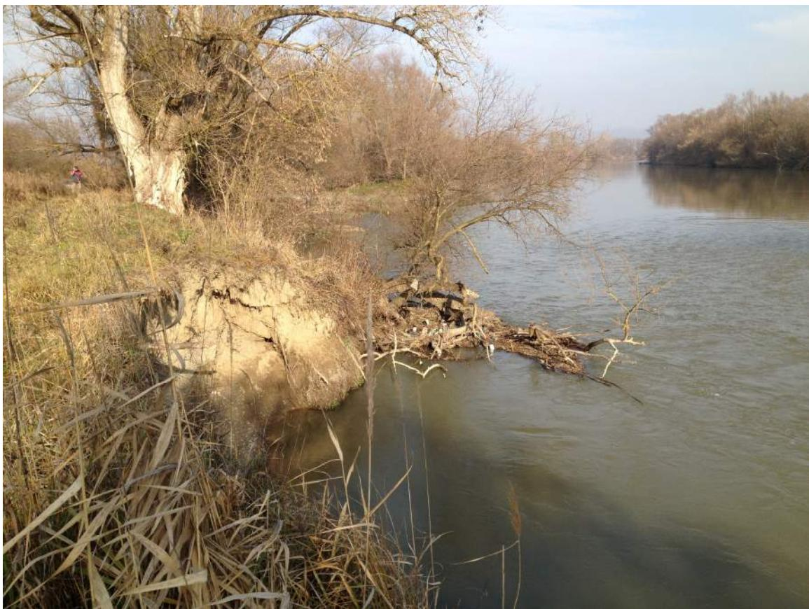
***Fig. 1 – Eroziune a malului stang in zona amplasamentului***
