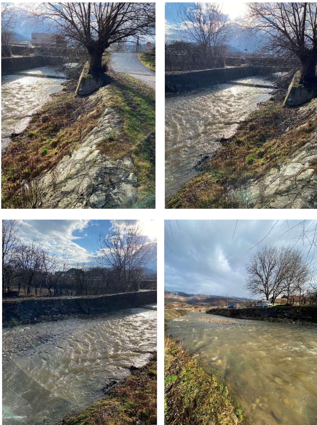
Figura 2 – Imagini cu consolidările și prag de cădere existent aval de drumul național DN66
