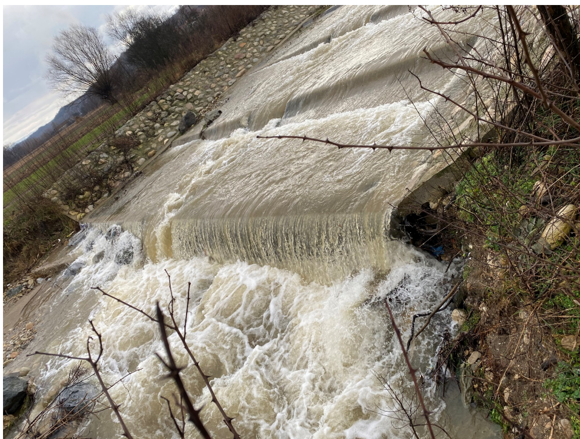
Figura 4 – Imagini cu pereul și pragurile de cădere existente aval de podul CF
