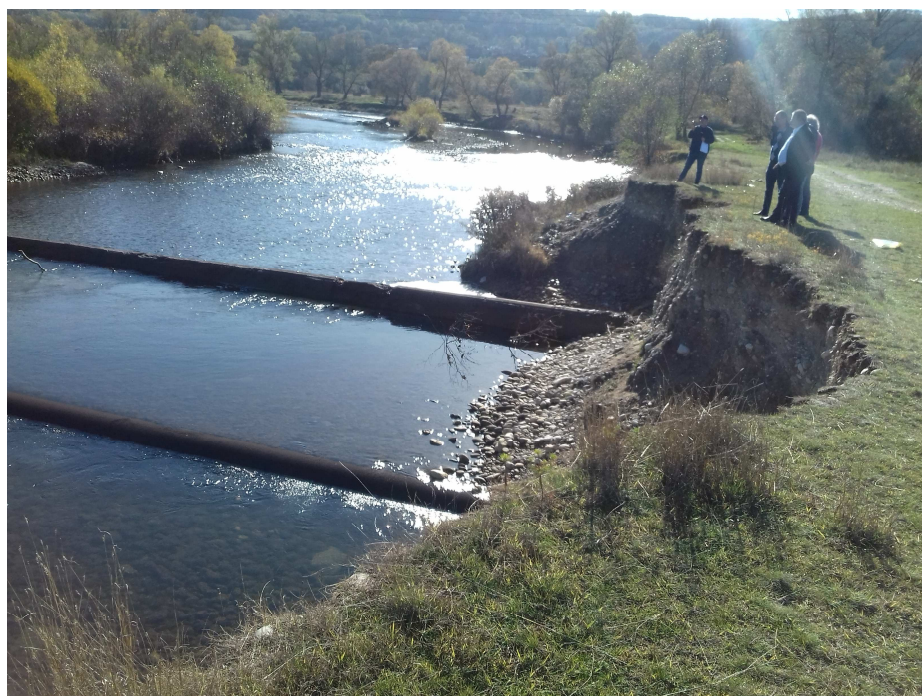
Traversare existentă râul Strei, cu cele două conducte de gaze
