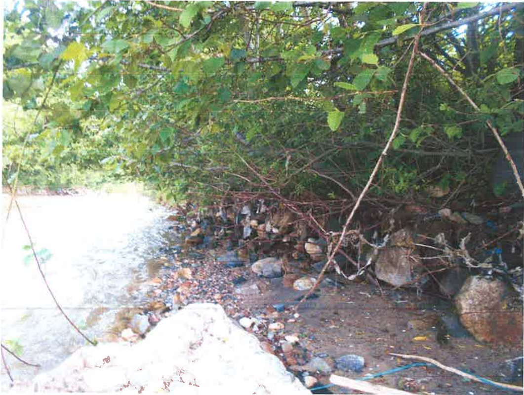
Foto 1 – râu Strei, saltea din gabioane la vedere în zona 1
