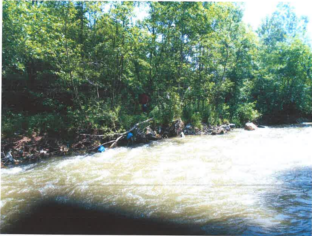
Foto 3 – râu Strei, saltea din gabioane la vedere în zona 3
