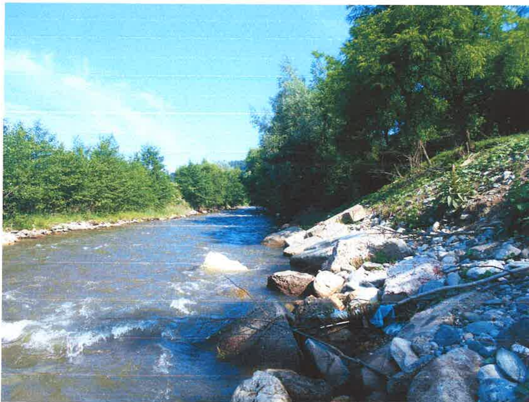
Foto 2 - rau Strei - vedere din sectiunea afectata de eroziune spre aval
