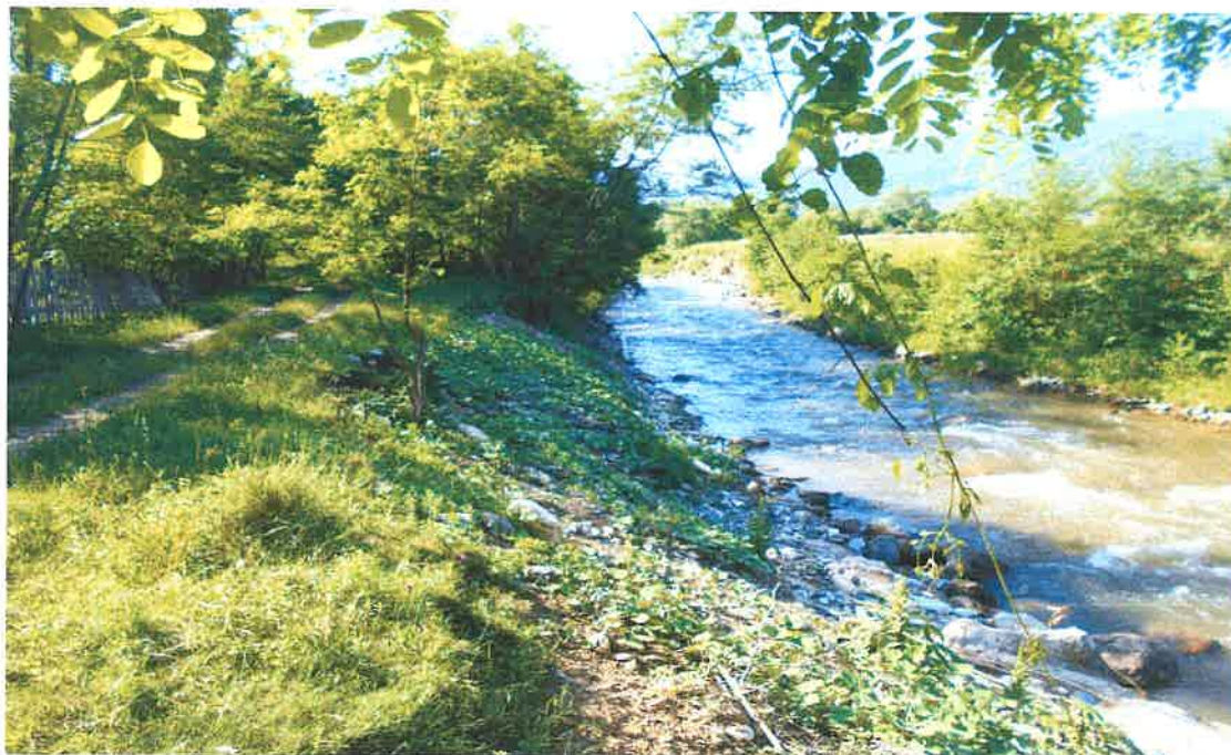
Foto 1 - rau Strei - vedere din secțiunea afectată de eroziune spre amonte
