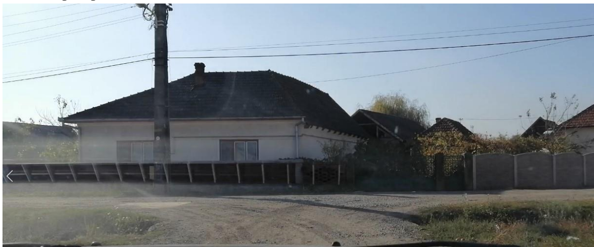
Statiua de pompare SPAU2:
